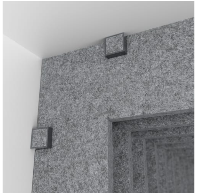
Baffle Systems Ying Yang Lite Corner Detail
